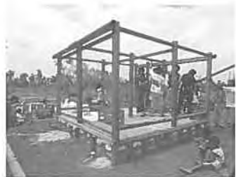
紙の筒を使用した 仮設住宅を建設 する様子
